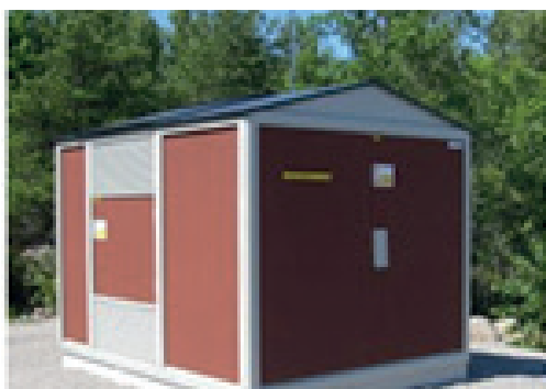
Bilden visar exempel på en nätstation (Källa: Ellevio)
