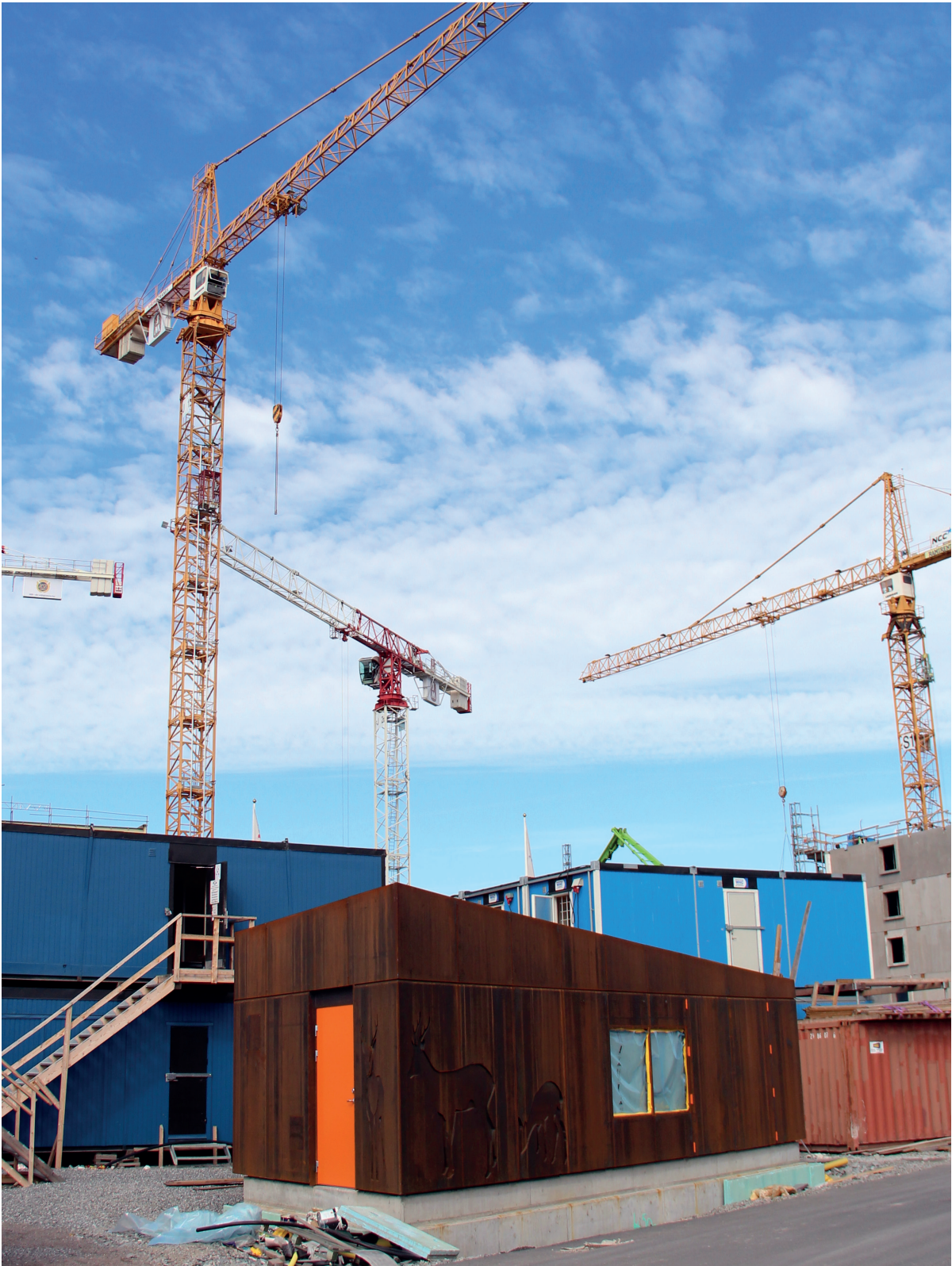
Bild på en elnätstation under konstruktion (Källa: Ellevio)
