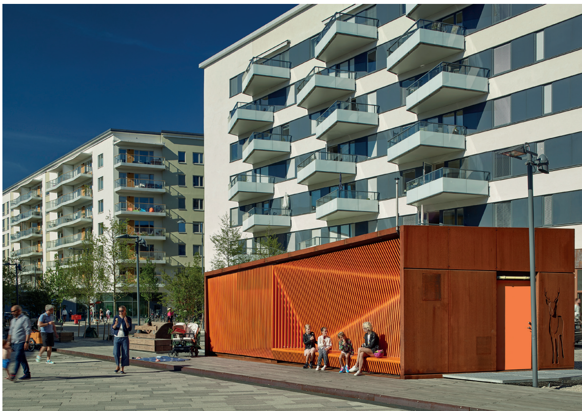
Bild på en nätstation i Norra Djurgårdsstaden (Källa: Ellevio)
