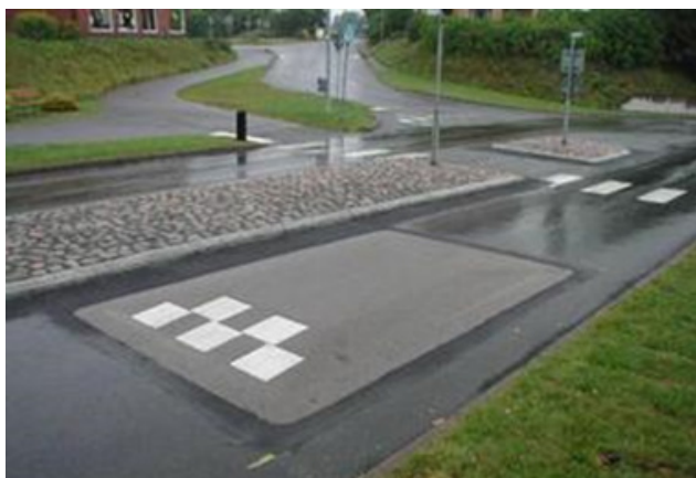
Exempel på busskudde vid cykelöverfart.
